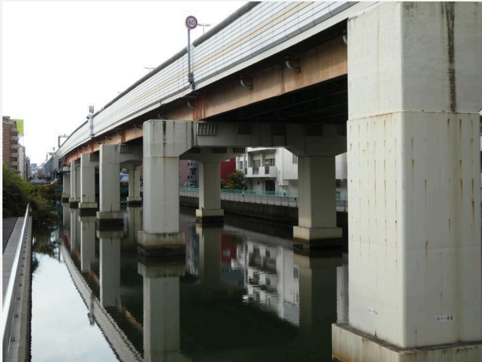
▲「豎川」の東端あたりの光景。高速道路を走っていても真下が川だなんて、きっと誰も気が付かないでしょう。写真の右下方向・東側に少し進むと、南北に流れる「大横川」に合流します。
