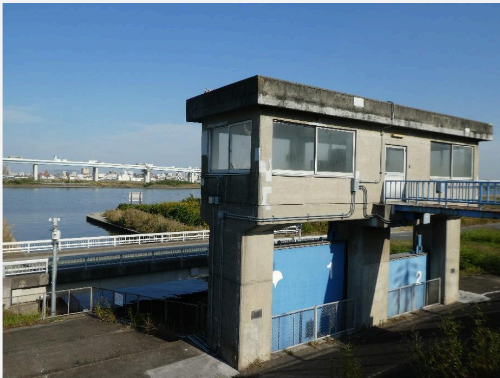
▲旧中川は、北端で荒川とつながっています。写真の「木下川(きねがわ)水門」は、大雨などで大量の水が荒川から旧中川に流入することを防ぎます。
